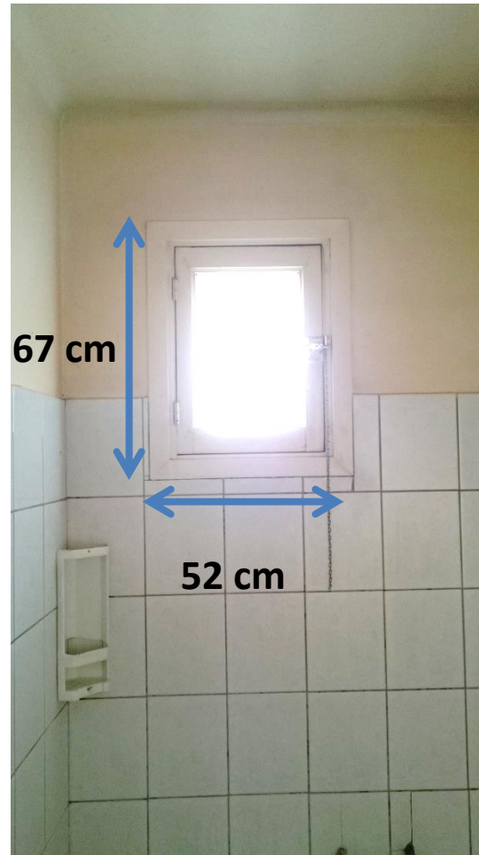
Logements – Menuiseries extérieures de type C WC + SdB
