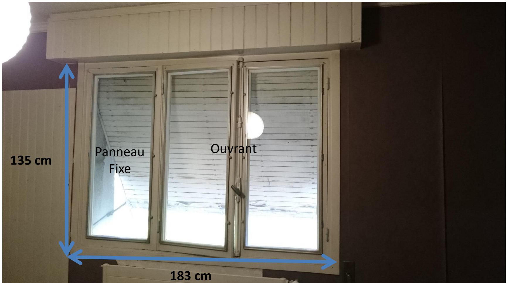
Logements – Menuiseries extérieures de type A Chambre n°1, n°2, + Salon
